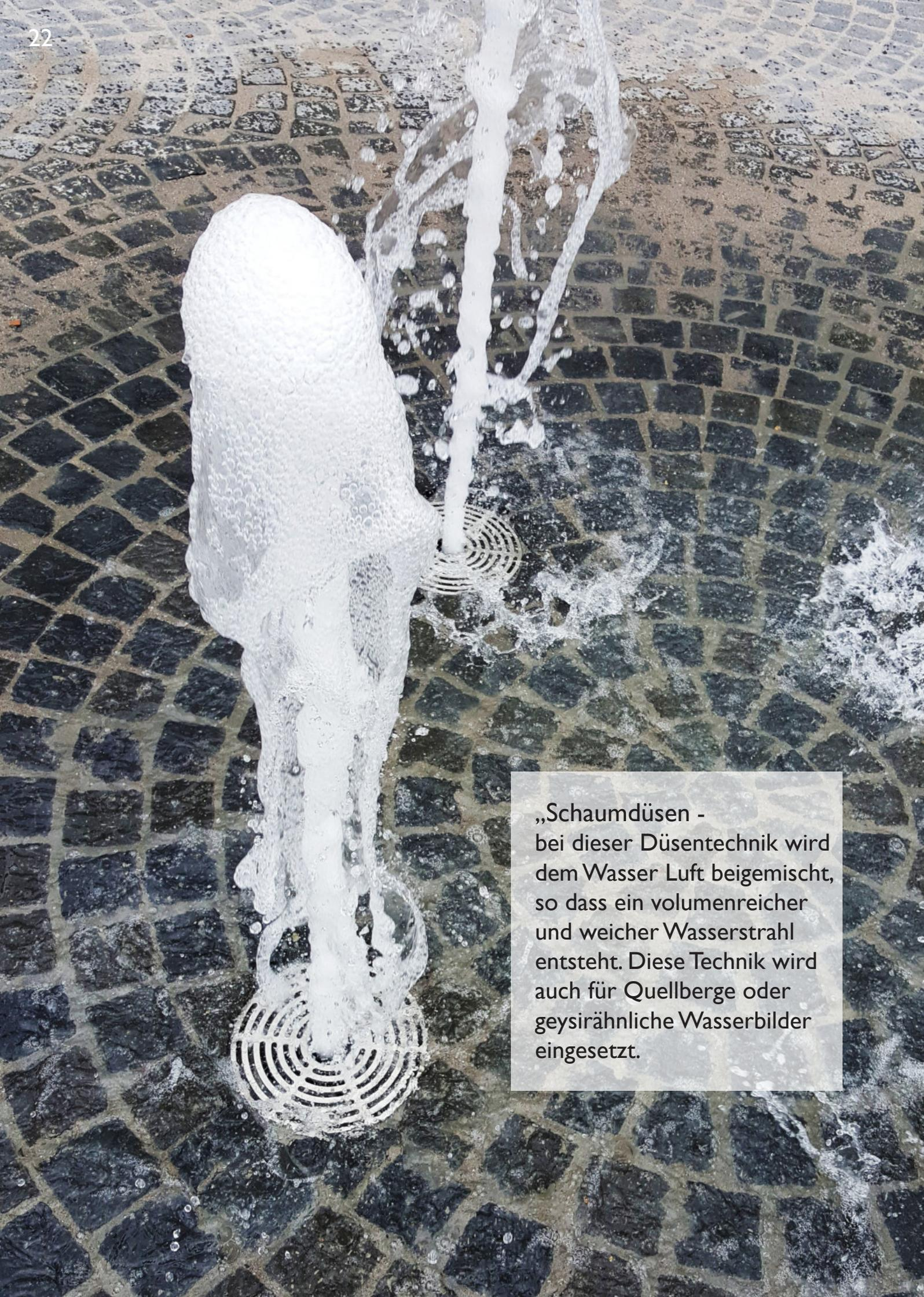
„Schaumdüsen - bei dieser Düsenteknik wird dem Wasser Luft beigemischt, so dass ein volumenreicher und weicher Wasserstrahl entsteht. Diese Technik wird auch für Quellberge oder geysirähnliche Wasserbilder eingesetzt.
